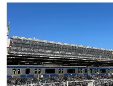
小山駅新幹線駅大規模改修
