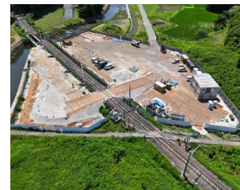
日光線 武子川橋りょう改築 (工事桁架設)
